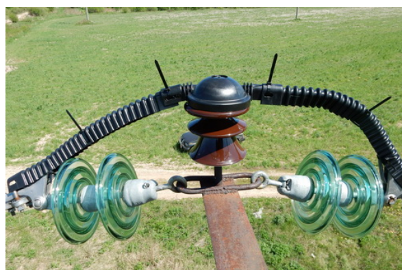
Гибкие кожухи позволяют выполнить защиту провода сложной конфигурации
