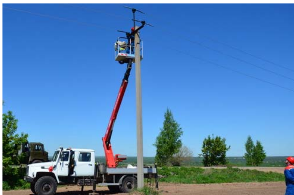
Монтаж ПЗУ 6-10 кВ КП-1 с использованием подъемной автотехники
